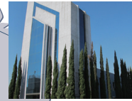
メキシコシティFAセンター Mexico City FA Center Mexico FA Center Mexico Branch, Mitsubishi Electric Automation, Inc.
