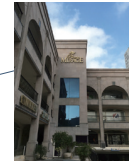
メキシコ・モンテレイFAセンター Mexico Monterrey FA Center Monterrey Office, Mitsubishi Electric Automation, Inc.
